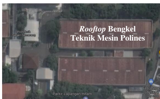
Gambar 1. Lokasi rooftop Bengkel Teknik Mesin Politeknik Negeri Semarang
